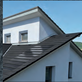
Dach und Fassade
