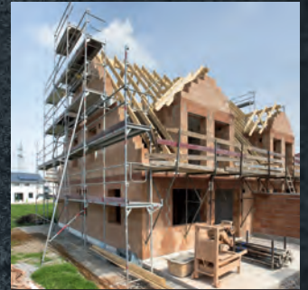
Roh- und Hochbau
