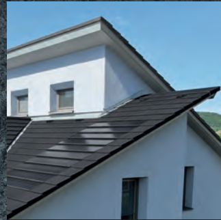
Dach und Fassade
