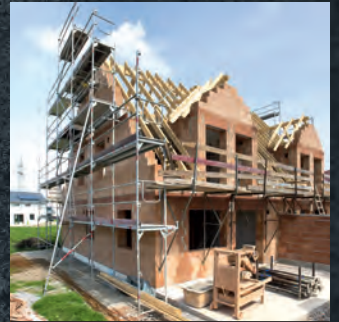
Roh- und Hochbau
