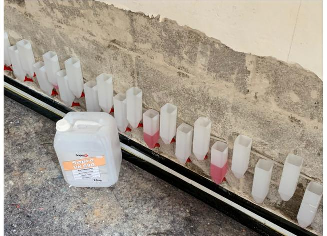
Bohrlöcher staubfrei machen und solange Sopro Verkieselung in die gesetzten Trichter einfüllen, bis keine Flüssigkeit mehr aufgenommen wird.
