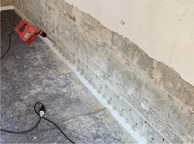
Die Bohrungen mit einem Durchmesser von 12 mm in einem Winkel von ca. 45 ° schräg nach unten bis ca. 5 cm vor Mauerende ausführen.
