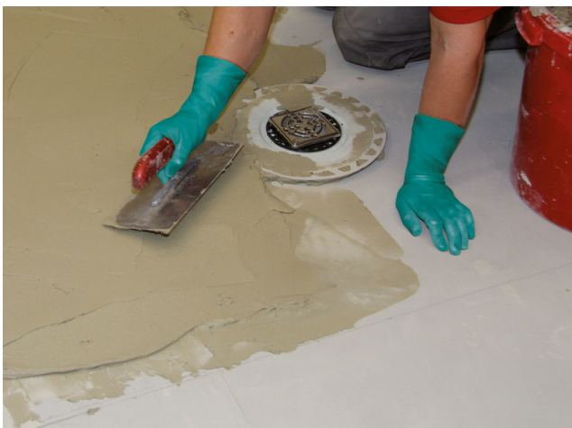
... und das Gefälle bis zu einer Spachteldicke von 10 mm für die nachfolgende Verbundabdichtung vorbereiten.
