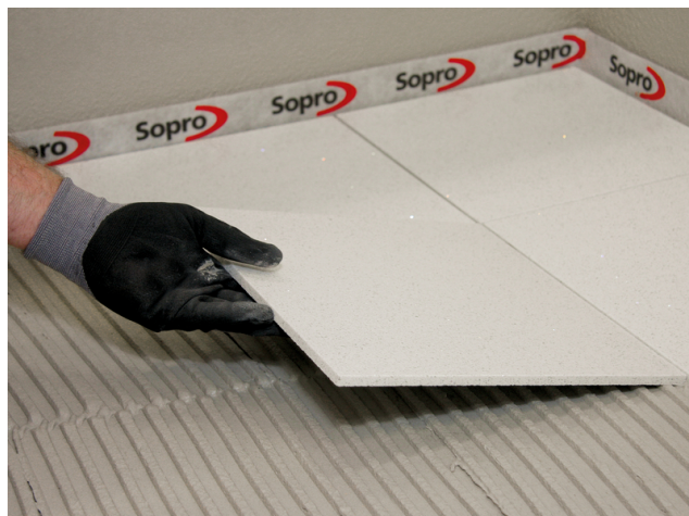
Einlegen einer Aggloplatte. Aufgrund der Schnellerhärtung eignet sich Sopro FKM® Silver auch für die Verlegung verformungsempfindlicher Beläge.
