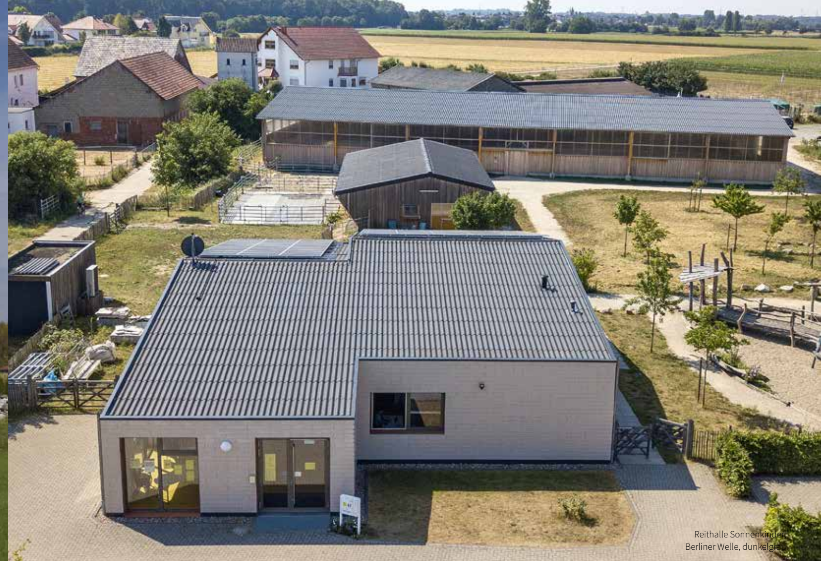
Einfamilienhaus, Heimertingen Wellplatten Profil 8, rostbraun
