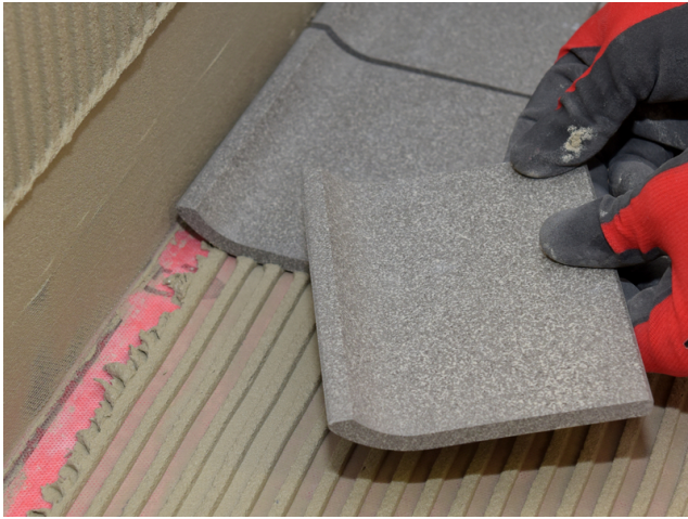
Anschließend werden wie gewohnt die Fliesen – hier Hohlkehlenfliesen – an Boden ...
