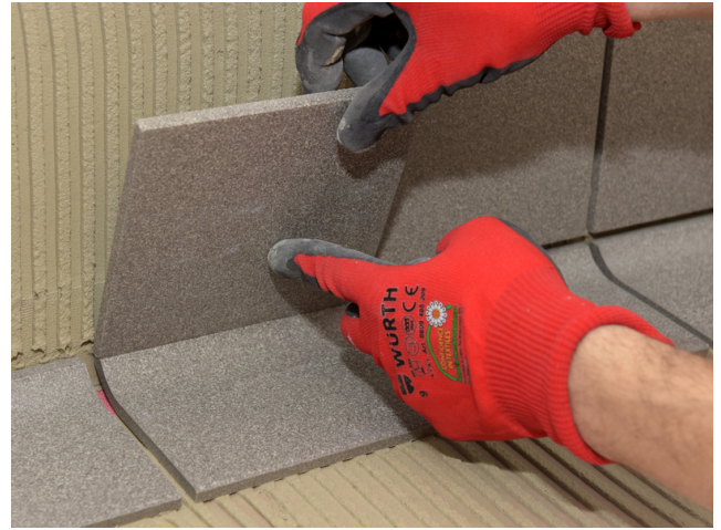
... und Wand verlegt.
