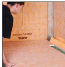
zu 3. Gefälleboard unter den Rand des Rinnenkörpers schieben
