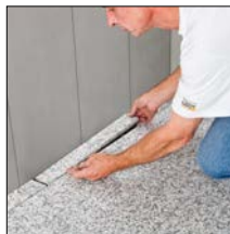
zu 6. Belag aufkleben – beim Verfugen Bereich des Belagträgers aussparen
