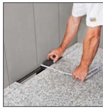
zu 4. Belag für den Belagträger bemessen...
