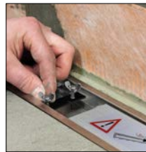
zu 2. Rahmen mit Hilfe der Höhenjustierung ...
