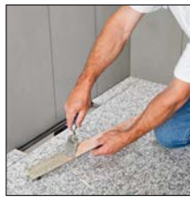
zu 5. Belagträger mit Dünnbettmörtel versehen
