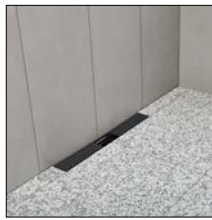
zu 3. Belag der Duschfläche anarbeiten
