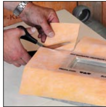
zu 1. KERDI-Manschette zerschneiden
