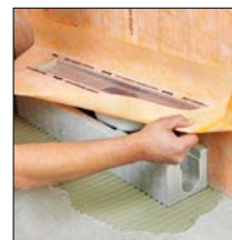
zu 2. Rinnenkörper einsetzen
