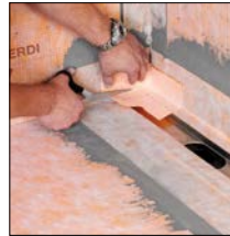
zu 2. KERDI-Manschette verkleben/ KERECK-Innenecke zerschneiden
