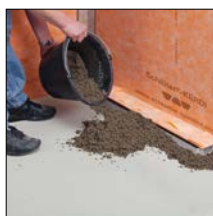
zu 5. Estrich aufbringen
