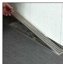
zu 4. Abdeckung einsetzen
