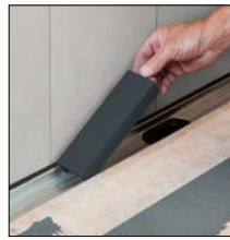
zu 2. Distanzstücke in den Rinnenkörper einlegen
