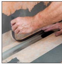
zu 1. Beim Wandeinbau: Abdeckstreifen zur Wand hin aufkleben
