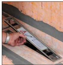
zu 1. Rahmen inkl. Distanzstreifen einsetzen
