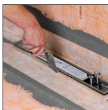
zu 3. Rahmen unterfüllen/ Fliesen vollflächig verlegen
