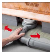
zu 5. Ablaufrohr ausrichten
