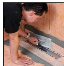
zu 4. KERDI-Manschette mit KERDI-COLL-L aufkleben
