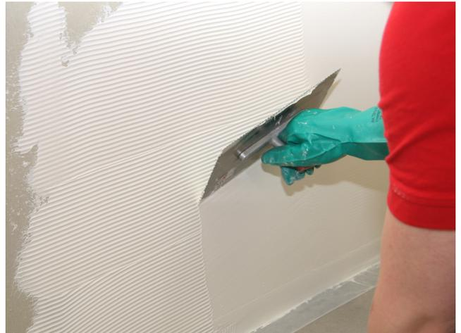
Sopro PU-FlächenDicht Wand aufzahn und anschliessend die Kammstege umlegen. Erforderliche Nass-Schichtdicke pro Abdichtungsschicht: 0,6 mm.
