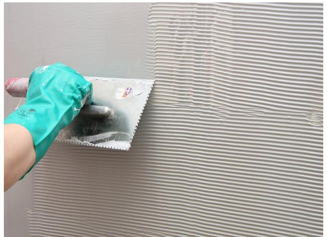
Der Auftrag der zweiten Abdichtungsschicht erfolgt analog der 1. Schicht durch Aufzahn und Umlegen der Kammstege.
