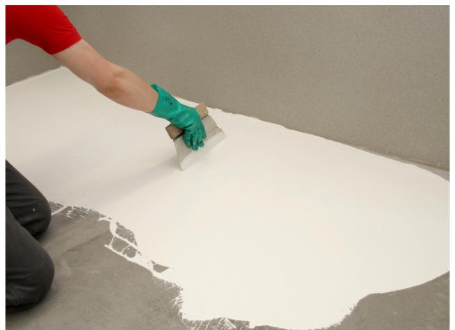
Am Boden PU-FD 1571 auftragen und mittels Stachelwalze entlüften, 2. Schicht mit Sopro Quarzsand grob absanden.
