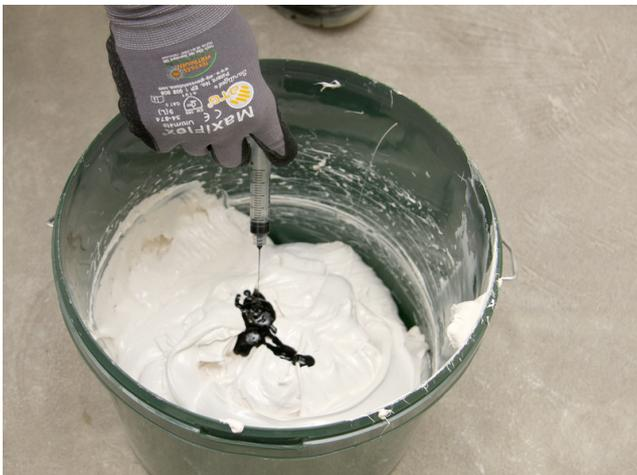
Nach 8 – 24 Stunden die zweite Abdichtungsschicht aufbringen. Zur besseren Unterscheidbarkeit mittels PU-KF in eine Kontrastfarbe einfärben.
