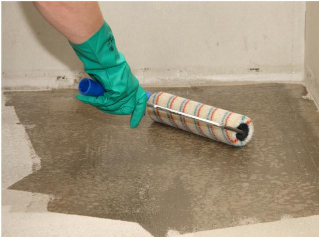
Den Untergrund mit Sopro Epoxi-Grundierung vorbehandeln und mit Sopro Quarzsand fein im Überschuss absanden.
