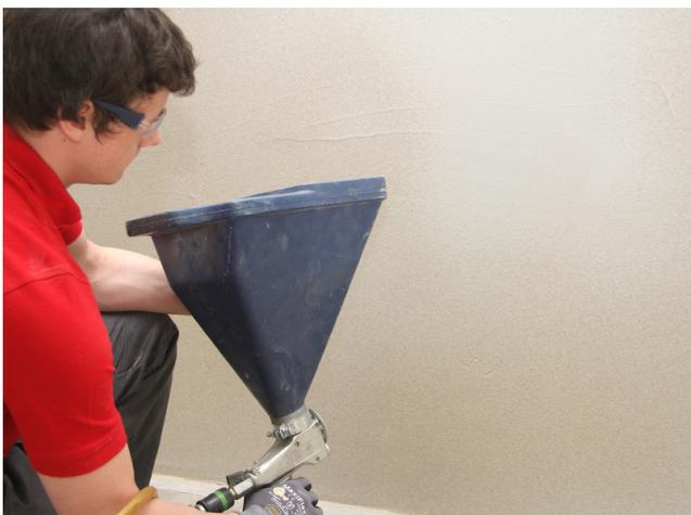
Nach 5 – 10 Minuten die 2. Abdichtungsschicht mit Sopro Quarzsand grob gründlich absanden.
