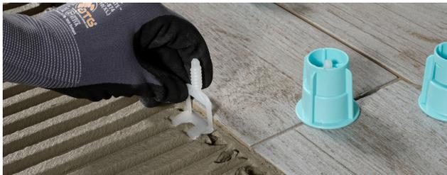
2. Dann wird der Drehknopf über die Gewindelasche geschoben. Diese rastet dabei hörbar ein. Nach wenigen weiteren Umdrehungen sind die Beläge perfekt nivelliert. Durch die griffige Größe geht das mühelos ideal für große Flächen.
